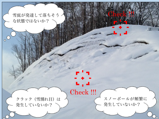
雪崩危険箇所点検
